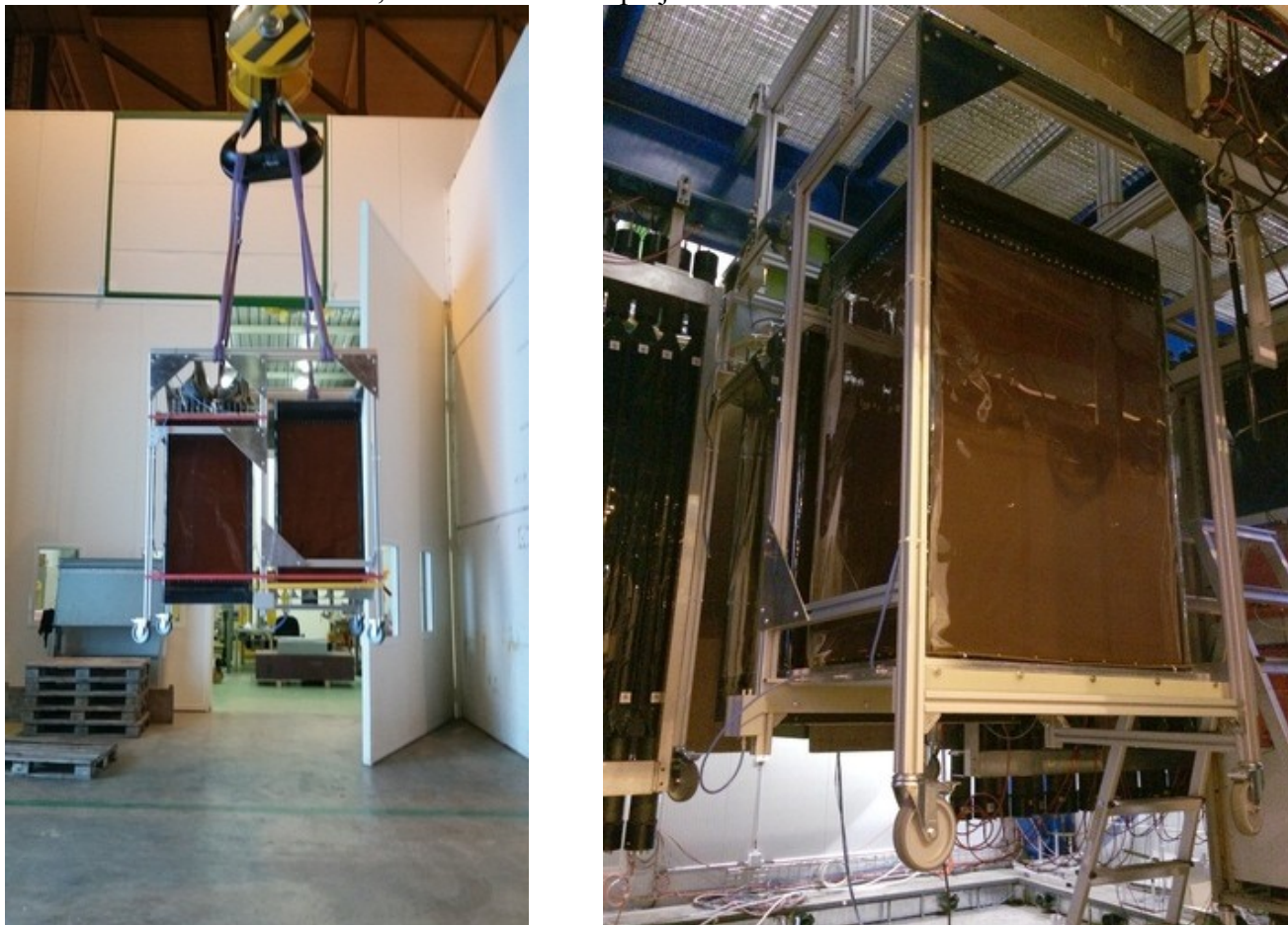
4.ábra: A kamrendszer utolsó, ún. tandem kamrapárjának beszerelése az NA61 kísérletbe.
